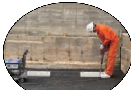
車止め設置工事
