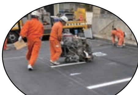
ライン引き工事
