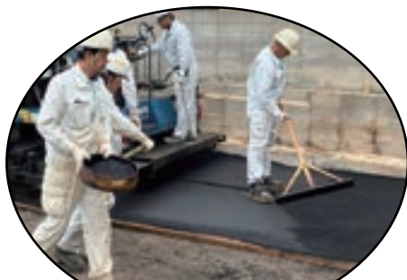
アスファルト舗装工事
